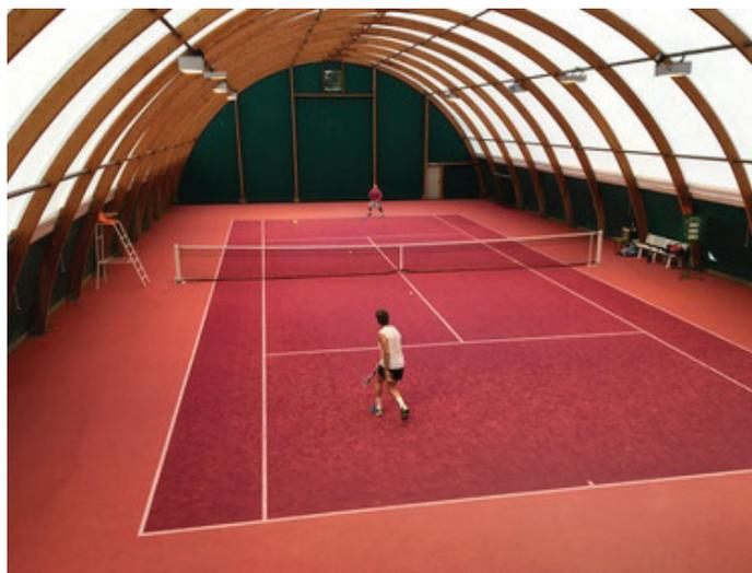
Suite à des dégradations liées à des infiltrations d'eau, la société SCI a entrepris fin juillet des travaux de réparation de plusieurs arcs de la charpente du tennis couvert : consolidation au pied par des lamelles, remplacement de la bâche d'aération latérale inférieure, avec 3 travées qui faciliteront leur manipulation par les joueurs.
