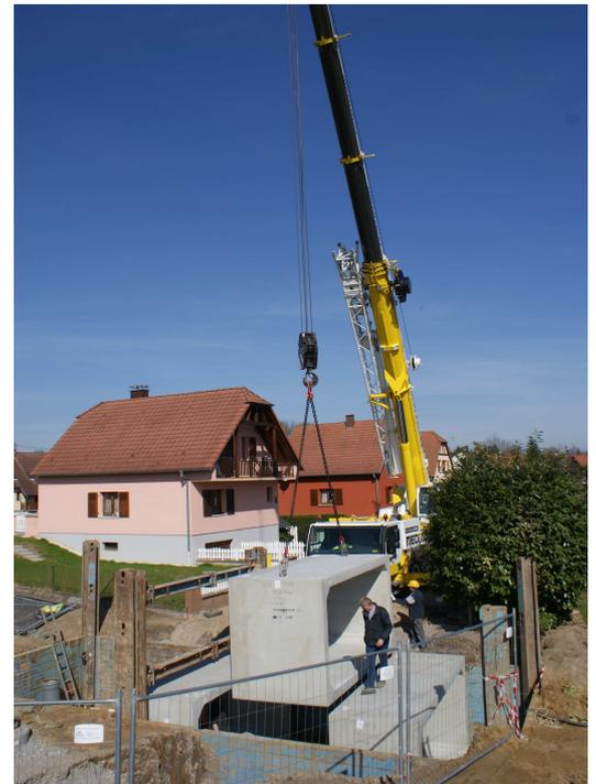
*Mise en place de l'un des éléments de l'ouvrage de franchissement du ruisseau*
