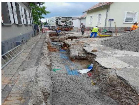
Rénovation AEP – rue Heyler à Hoerdts
