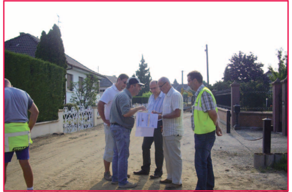
André GARNIER, adjoint chargé des travaux, a suivi l'avancée du chantier.
