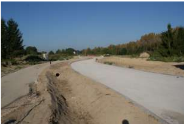
FILTRE DE RETENTION PLANTÉ DE ROSEAUX
