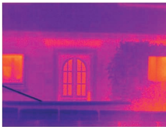
Ici certains éléments de construction comme les linteaux peuvent être une faiblesse dans la maison.
