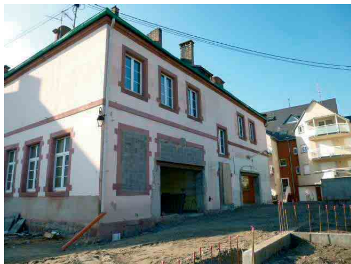
Arrière du bâtiment avec les deux grandes baies des salles d'activités ( anciennes salles de classe )
